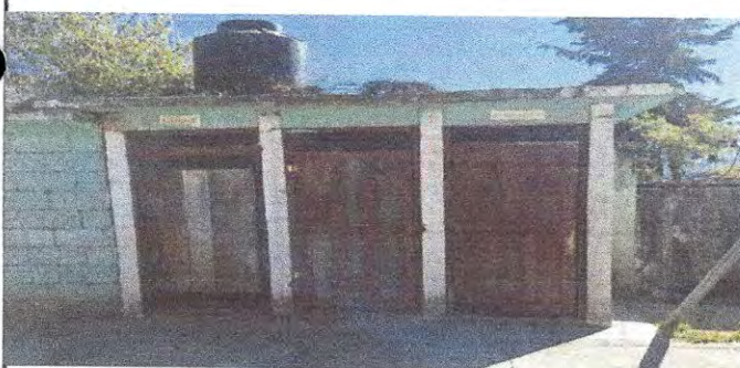
Foto 5: Sustitución de puertas del servicio sanitario de 6 mts cuadreados
