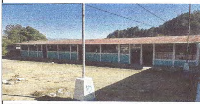
Foto 2: En la se observa la lámina del techo que será sustituido por lámina troquelada aluzinc calibre 26 que será de 306.99 mts cuadrados
