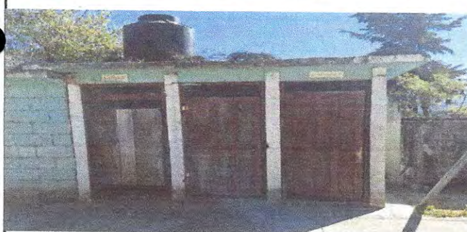
Foto 5: Sustitución de puertas del servicio sanitario de 6 mts cuadrados
