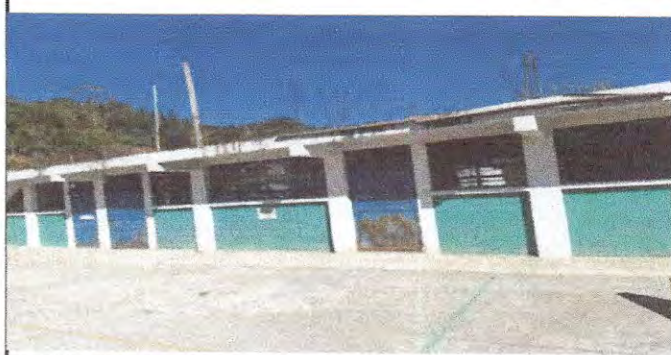
Foto 4: En la foto se observa las puertas a sustituir 7.434 mts cuadrados
